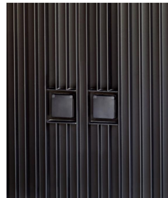
Allo stesso modo, è possibile integrare anche una presa elettrica o un rubinetto per l'acqua.
