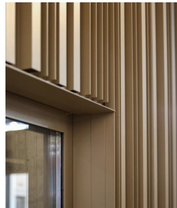
Profili di finitura per i bordi, perfettamente abbinati al colore, alla consistenza e alla qualità del rivestimento di facciata Linarte.
