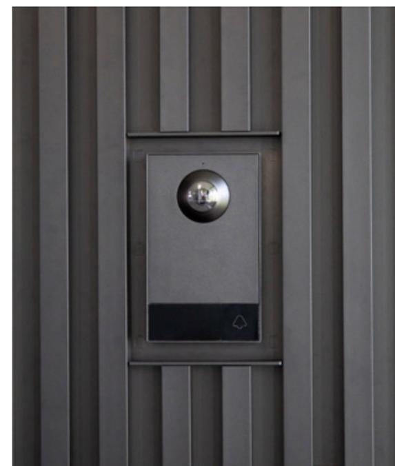
La videocitofonia è integrata nel rivestimento della facciata tramite moduli appositamente sviluppati, con una placca cieca nella stessa finitura della facciata.
